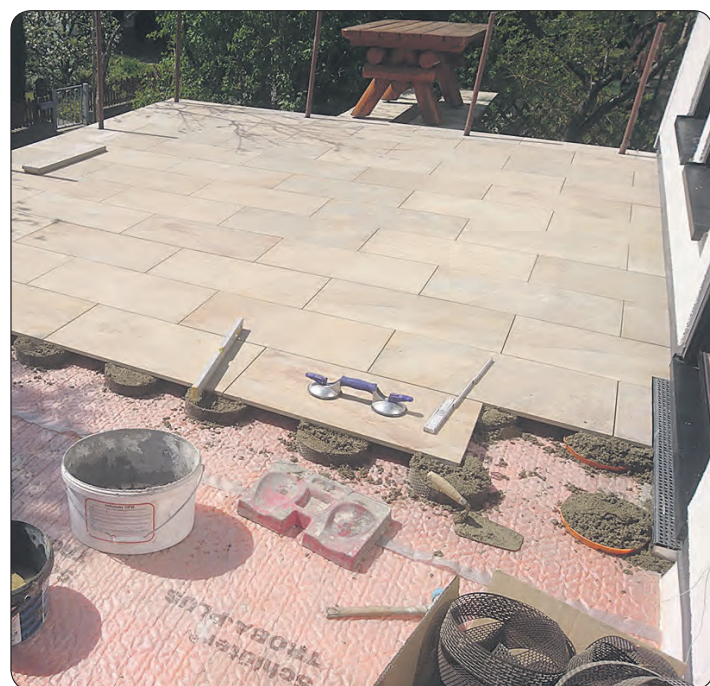
Perfektes Material: Verlegung von Terrassenplatten auf Stelzlager
